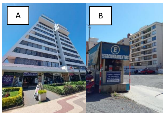
Figura 10. Edificaciones asociadas al servicio de transporte
